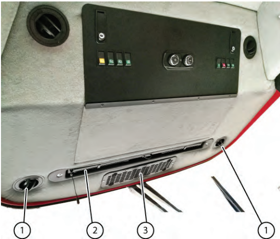
Fig. 17 Éléments à l'avant dans la cabine
